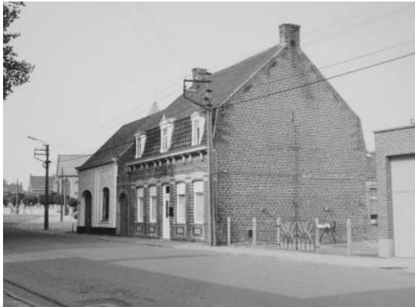
Figuur 58 : deels afgebroken hoppemagazijn (links) en vml. café de hoppepers (rechts) (foto Onroerend Erfgoed 1982)
