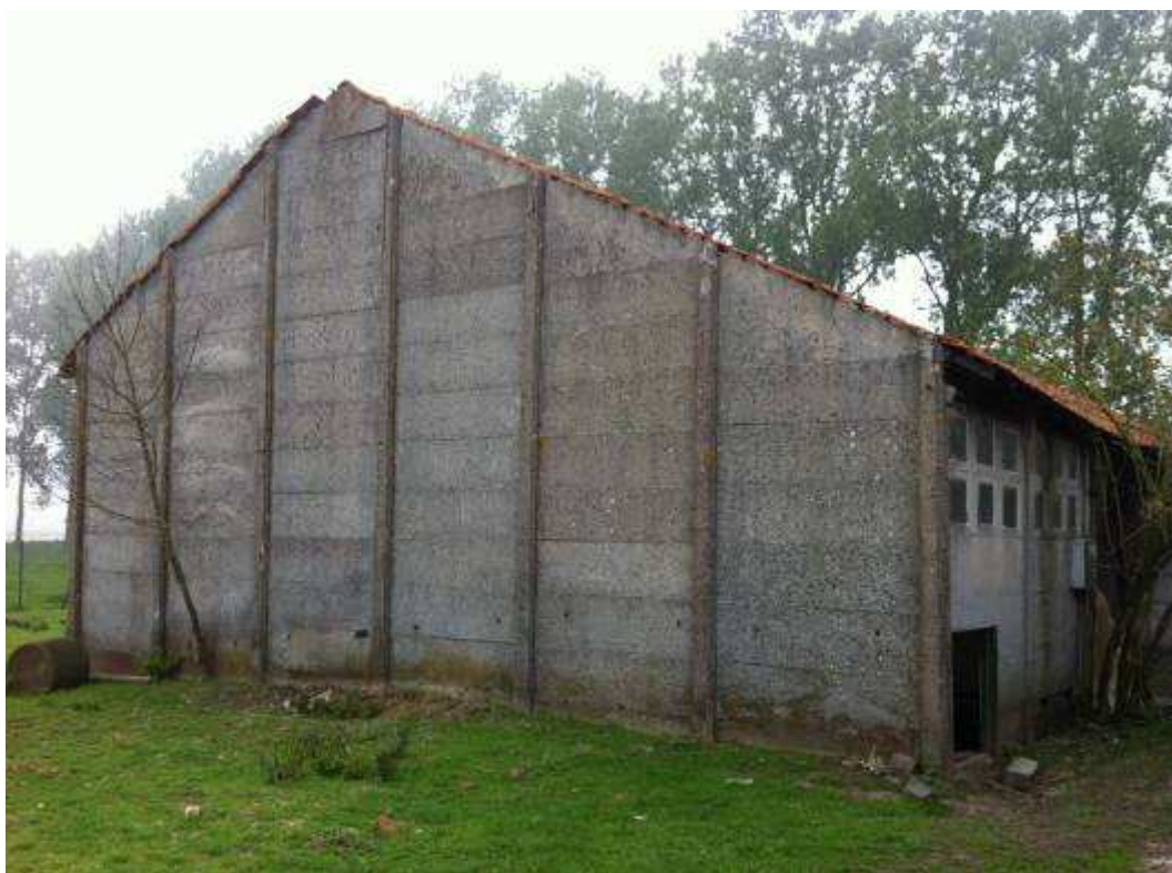
Figuur 140 : betonnen loods (foto Onroerend Erfgoed 2011)
