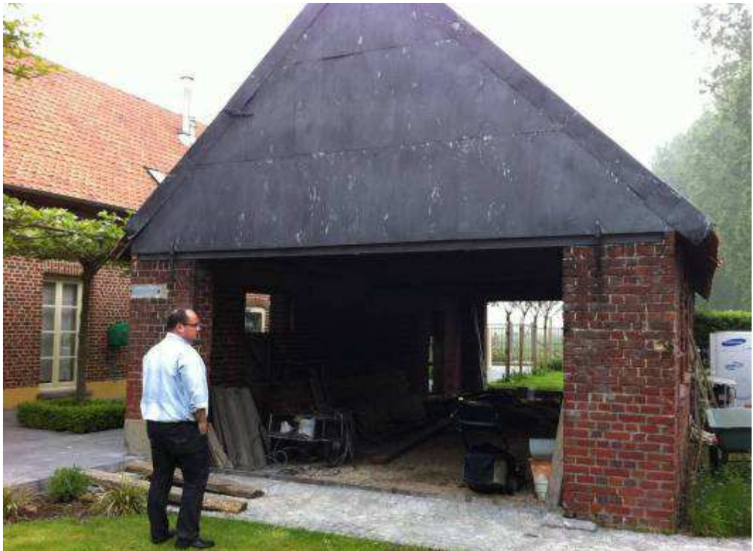
Figuur 137 : foto overdekte mestvaalt westgevel (foto Onroerend Erfgoed 2011)
