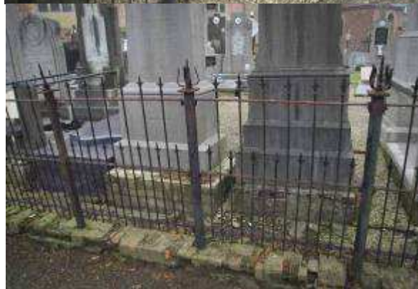
Figuur 212 : hekwerk type 3 – uitvoering hoge panelen en hergebruik gietijzeren palen (foto auteur 2009)
