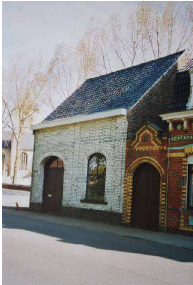
Figuur 59 : deels afgebroken hoppemagazijn (foto Onroerend Erfgoed 1996)
