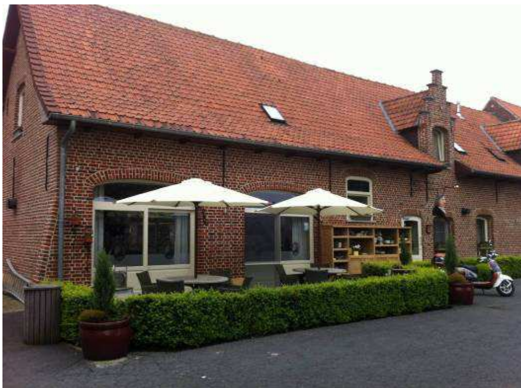
Figuur 130 : voorgevel 20 ste -eeuwse stallen (foto Onroerend Erfgoed 2011)
