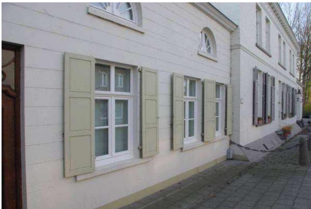
Figuur 95 : Zevekotestraat 8 - vervangen schrijnwerk (foto auteur 2011)
