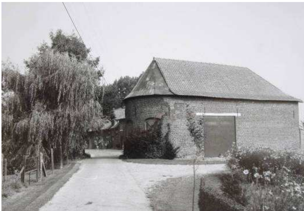
Figuur 106 : 18 de -eeuwse schuur in 1982 (foto Onroerend Erfgoed)
