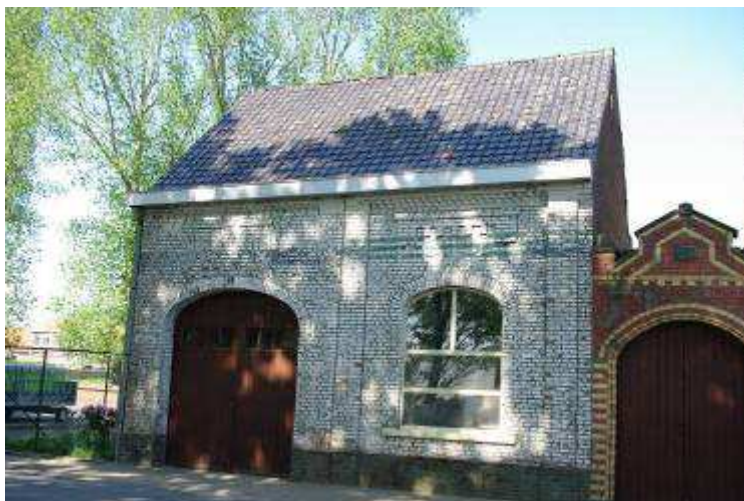
Figuur 60 : deels afgebroken hoppemagazijn (foto auteur 2010)
