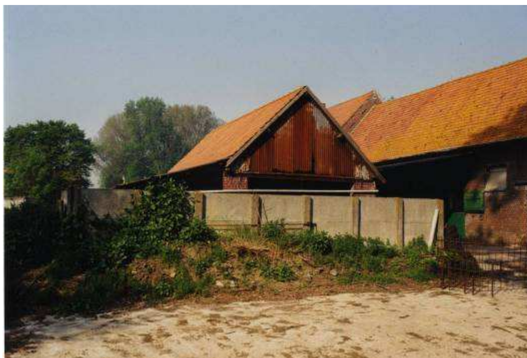
Figuur 121 : overdekte mestvaalt oostgevel in 1998 (foto privé-collectie)
