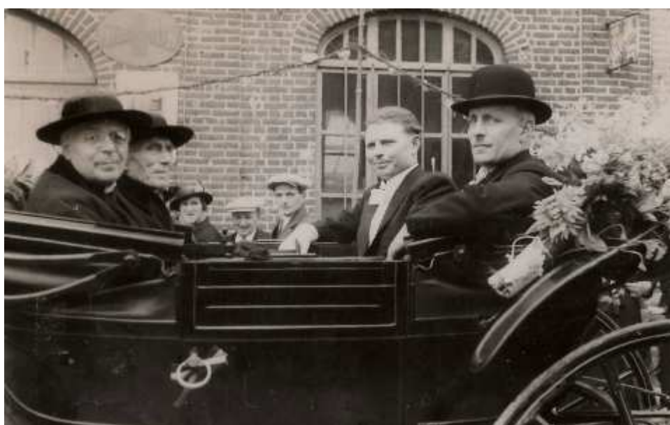
Figuur 57 : foto Westhoek Verbeeldt HEU004503723 (1950 – privéverzameling) : details schrijnwerk
