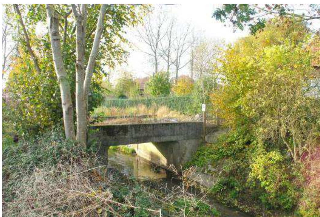
Figuur 237 : betonnen brug in het verlengde van de dreef
