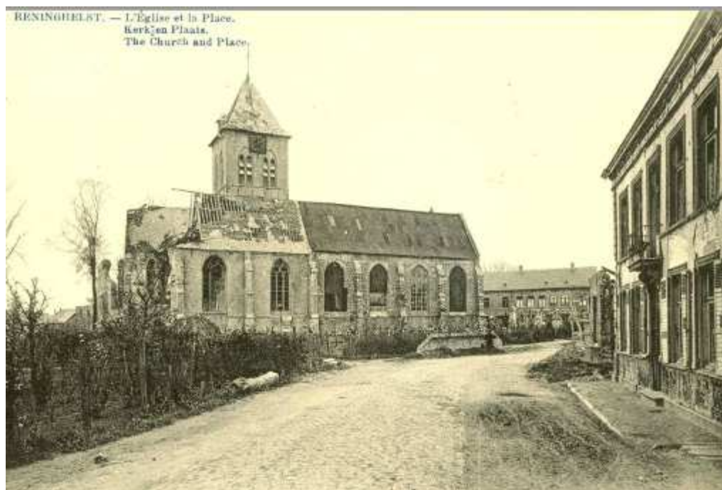
Figuur 203 : Beschadiging kerkhofmuur langs de Pastoorstraat (verder ingelezen) – links op de voorgrond de haag en lage aanplantingen t.h.v. Pastoorstraat 2. Bemerkt rechts het nog gespaarde gebouw (zr. nr. tussen Zev ekotestraat 13 en 15) bewaard evenwel zonder gevelopsmuk – postkaart Westhoek Verbeeldt HEU004500887 (privéverzameling)
