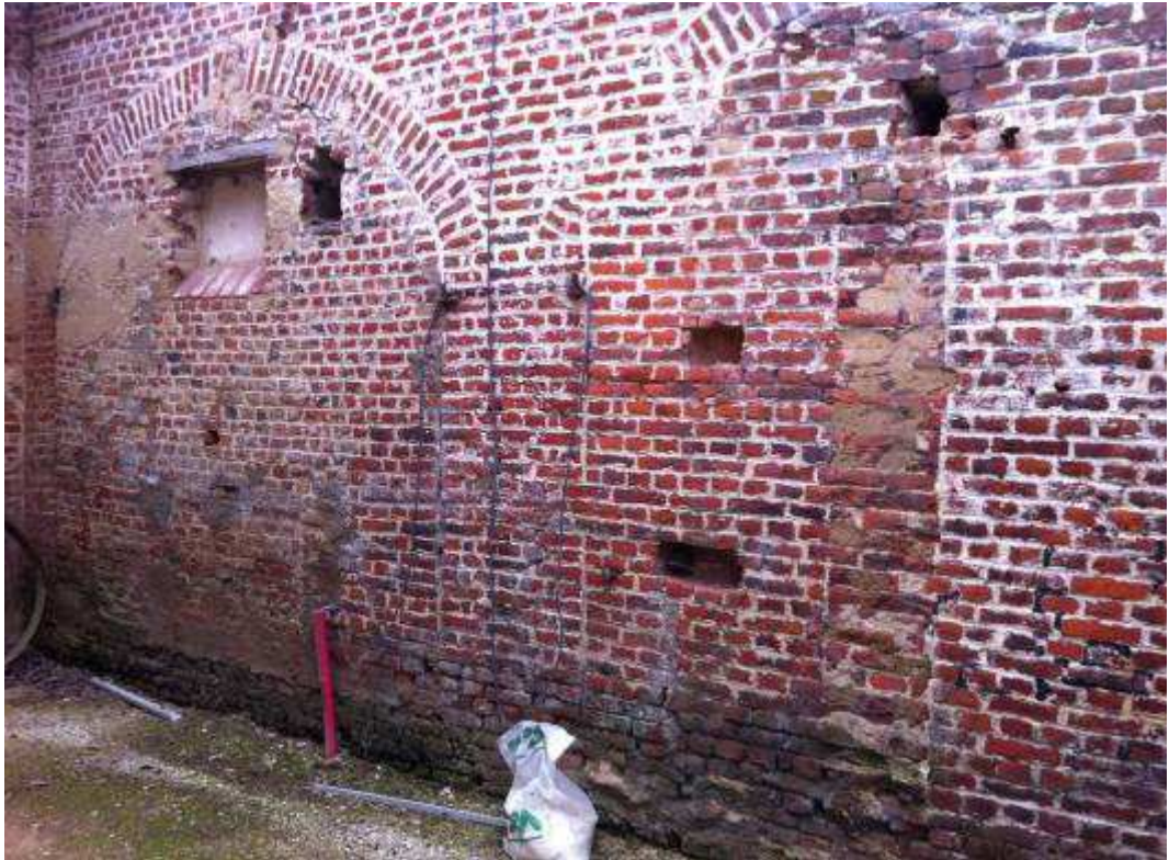
Figuur 132 : oostgevel van de 18 de -eeuwse schuur (foto Onroerend Erfgoed 2011)
