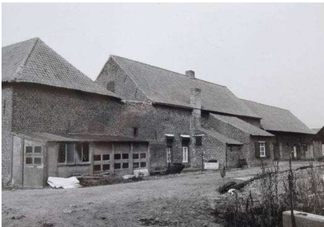
Figuur 107 : achtergevel 18 de -eeuwse schuur en woonhuis met de volumes van de bakoven (eigenlijke bakoven en bakhuis) aanpalend aan het woonhuis. Aansluitend rechts de 20 ste -eeuwse stallen. Foto uit 1982 (foto Onroerend Erfgoed)
