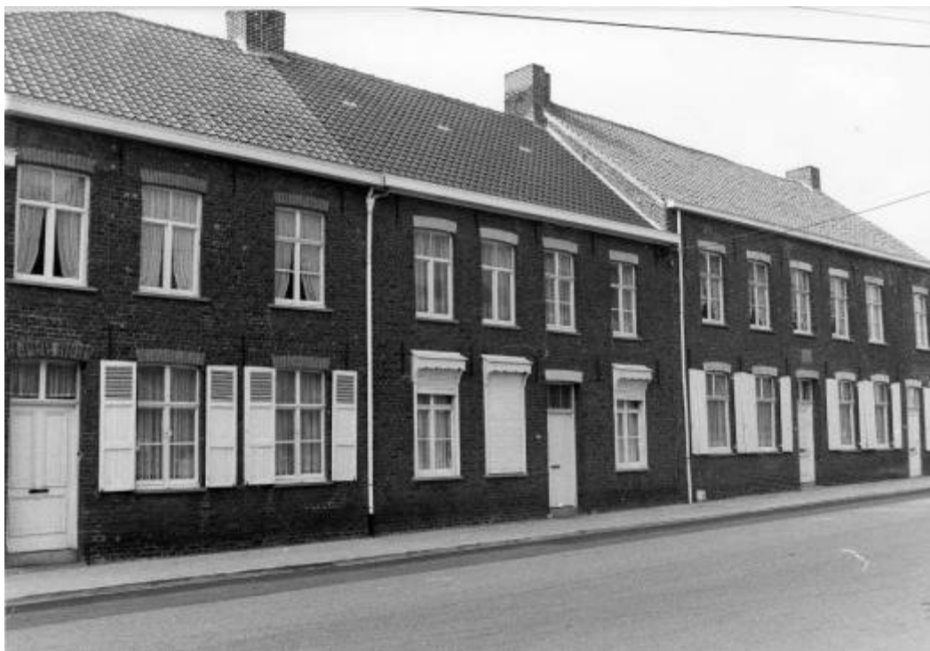
Figuur 37 : Baljuwstraat 25, 27 en 29 - deels reeds verbouwde situatie (foto OE 1982)
