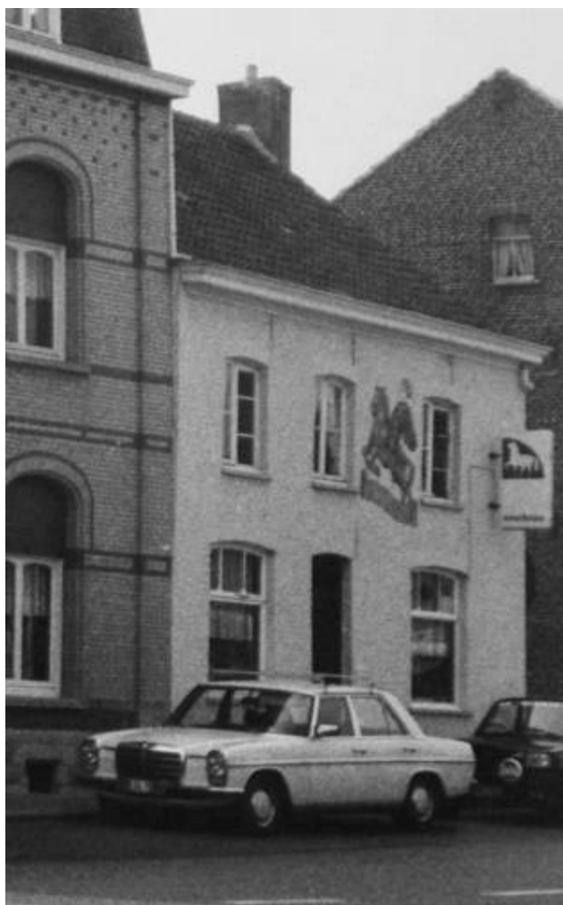
Figuur 162 : Reningelstplein 7 (foto Onroerend Erfgoed 1982)
