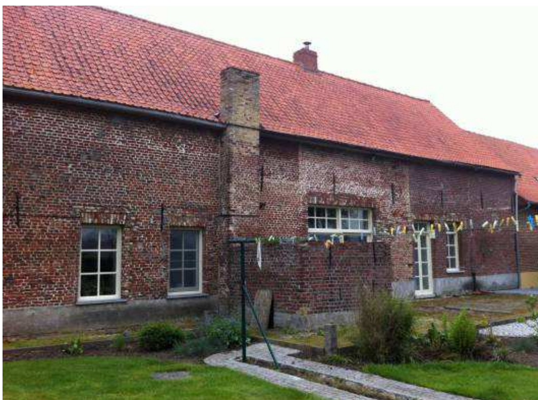
Figuur 135 : achtergevel van het 18 de -eeuwse woonhuis met afgebroken bakhuis en van dak ontdane bakoven (foto Onroerend Erfgoed 2011)
