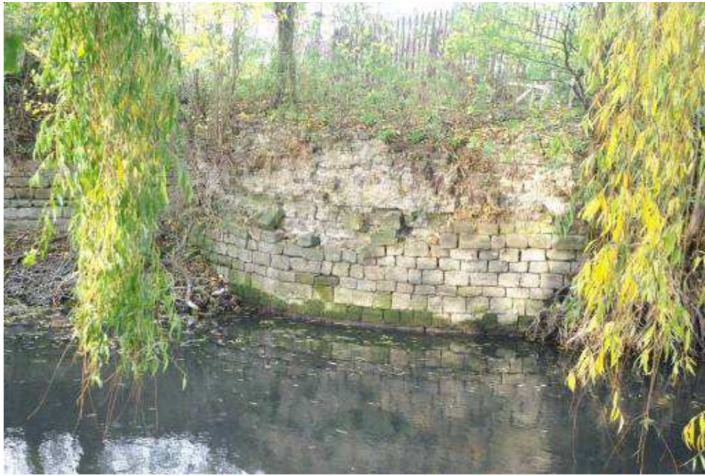
Figuur 18 : behouden basis van de zuidwestelijke torenaanzet (foto auteur 2011)
