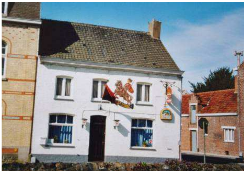
Figuur 163 : Reningelstplein 7 (foto Onroerend Erfgoed 1994)
